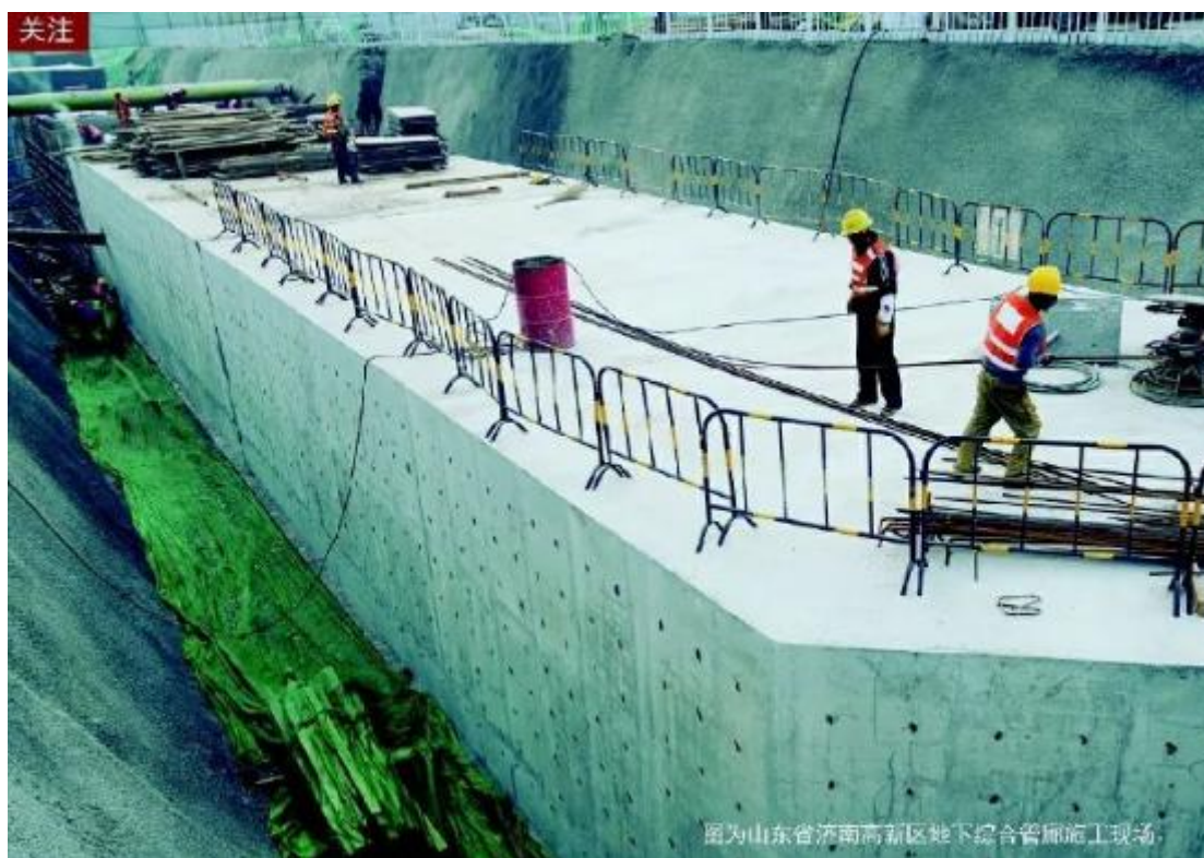
图为山东省济南高新区地下综合管廊施工现场
